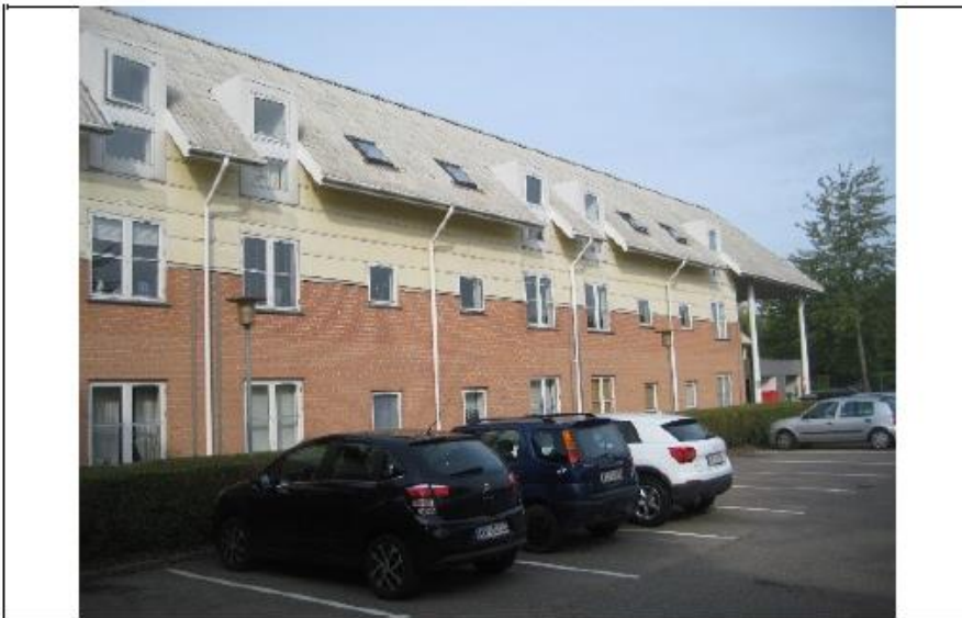
Vinduer og døre i facade
