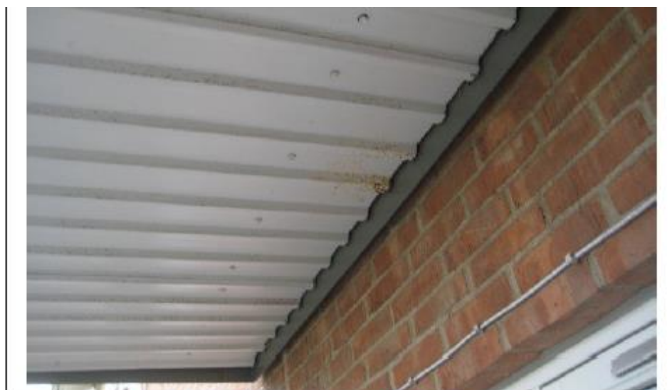
Trapezplade på underside af repos – nr.142
