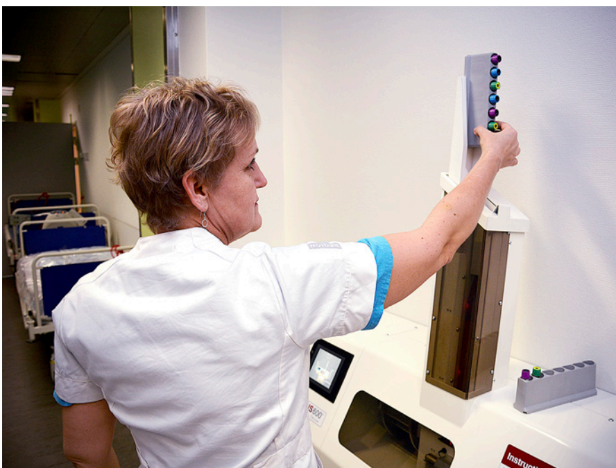
Bioanalytiker Anette Reimann demonstrerer, hvordan blodprøverne 'loads' i en afsenderstation på hospitalets nye rørpost-system (Tempus600 fra Timedico). Foto: Thomas Wittrup
