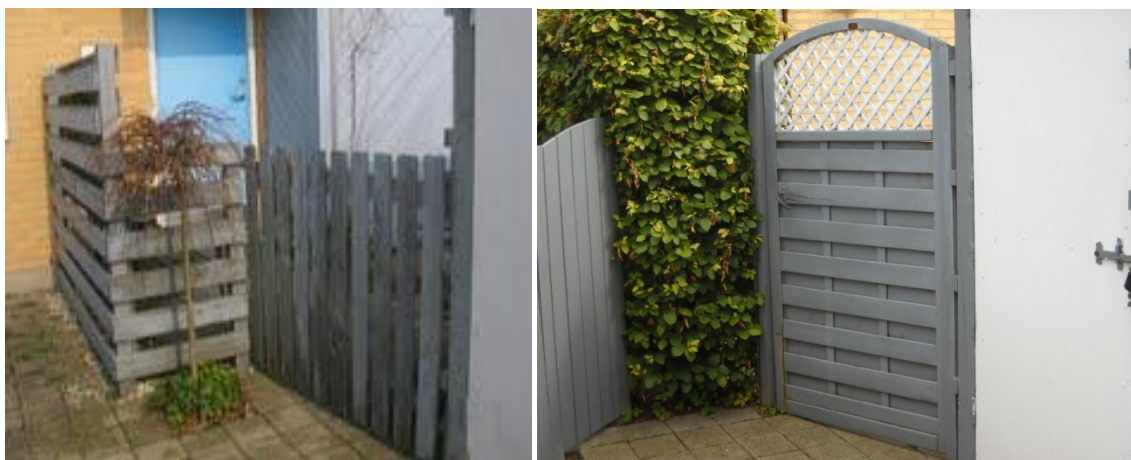
Eksempler på et hegn og låger i forhaven (ved indgangsdørene).
