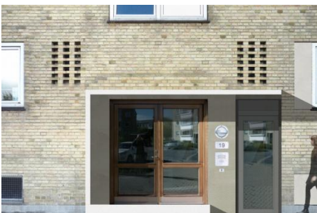
Indgangsparti ved elevatorbetjente lejligheder.
